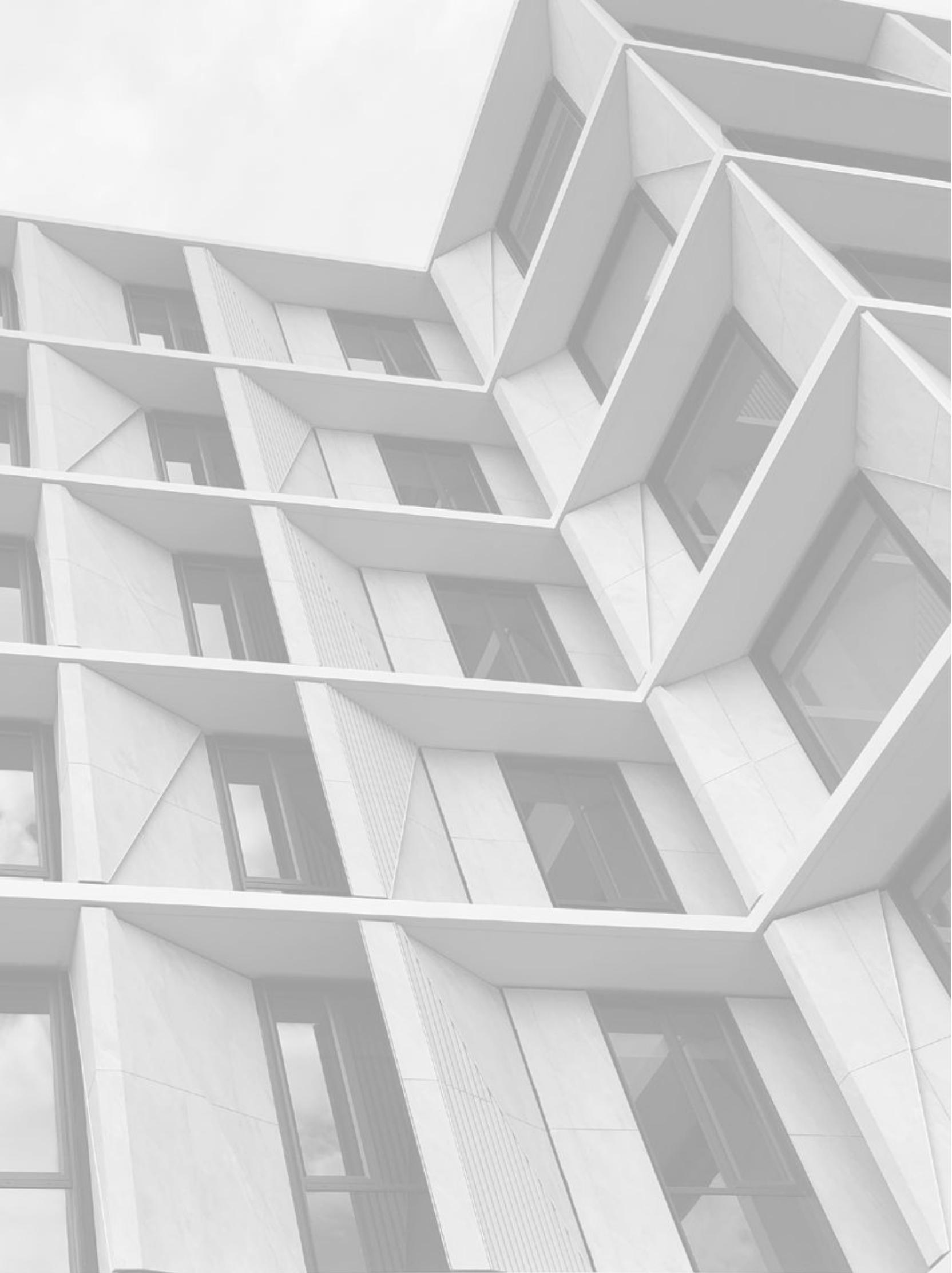
Los últimos avances tecnológicos permiten la fabricación de Frontek, unas piezas de porcelánico por extrusión que poseen una gran dureza, ligereza y resistencia, ideales para el revestimiento de fachadas. Su exclusivo sistema alveolar caracteriza la colección, dotando a las piezas de una firme estructura al mismo tiempo que se reduce notablemente su peso.
